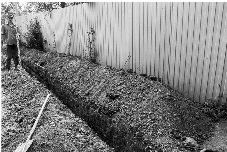
Рис. 2. Траншея для укладки газопровода на площадке грунтового могильника XVI–XIX вв. в с. Молоди, г. о. Чехов Московской области
