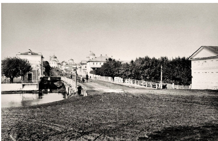
Рис. 1. Царский мост на фото 1880–1889 гг. Архив МИЕ, НВФ 8960
